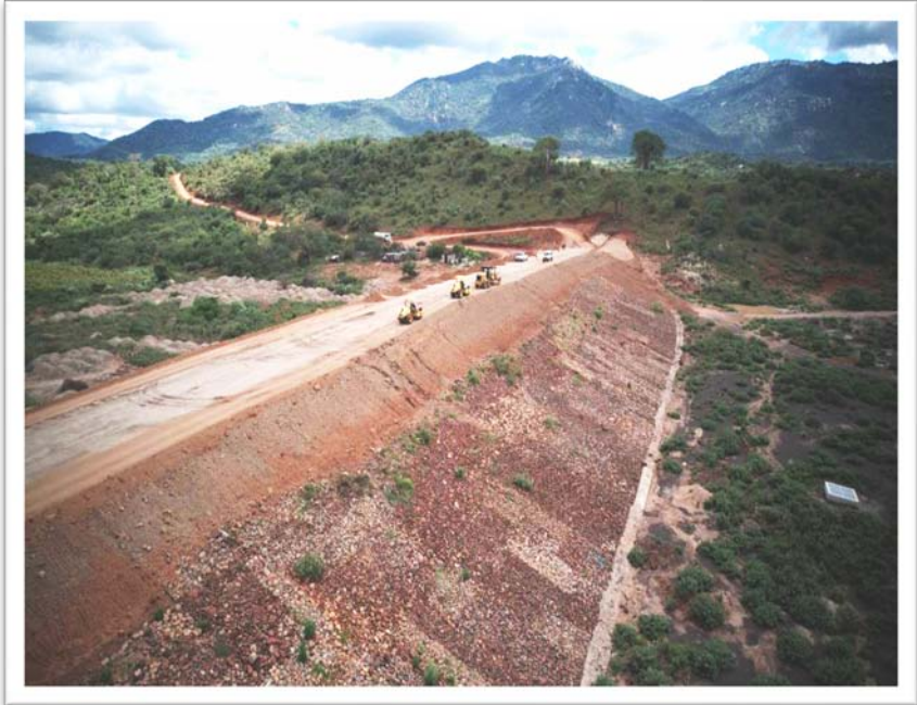
Picha Na.7: Ujenzi wa tuta la bwawa katika Mradi wa Umwagiliaji - Membe Dodoma
